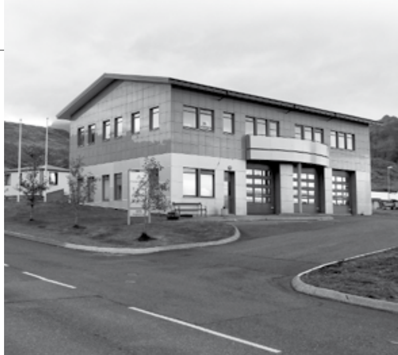
► Die Bibliothek von Grundarfjörður teilt sich das Haus mit der Feuerwehr
